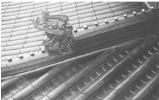
图 6 雷峰新塔铜瓦
